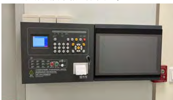
放射性废水槽式衰变池控制系统
