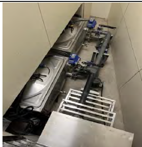
放射性废水槽式衰变池( 2\times 2\text{m}^3 )
